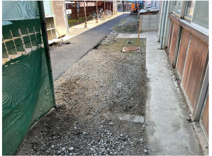
←写真1 ↑写真2 工事前
